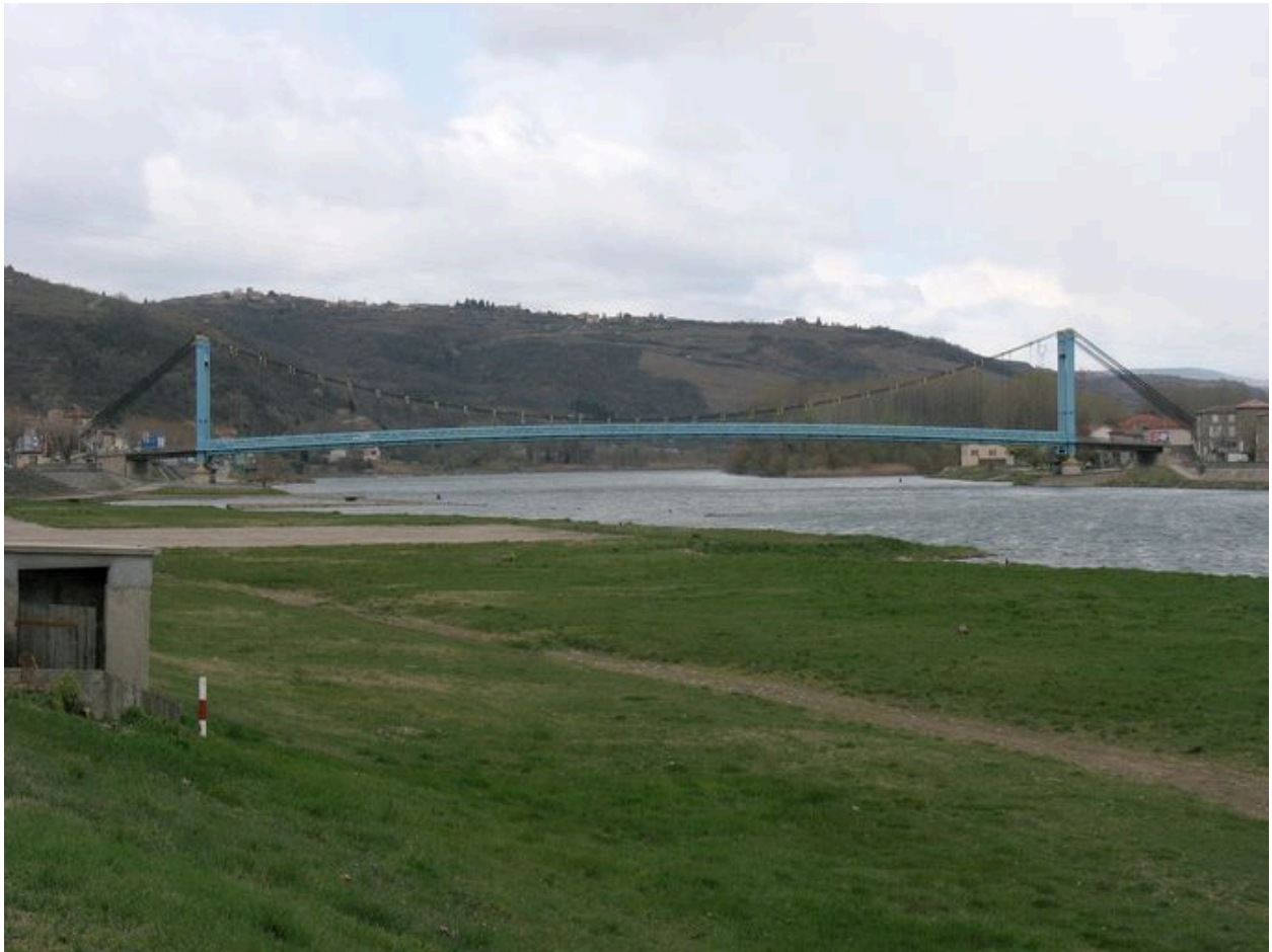
Vue du pont dans le site, face aval (depuis la rive droite)
