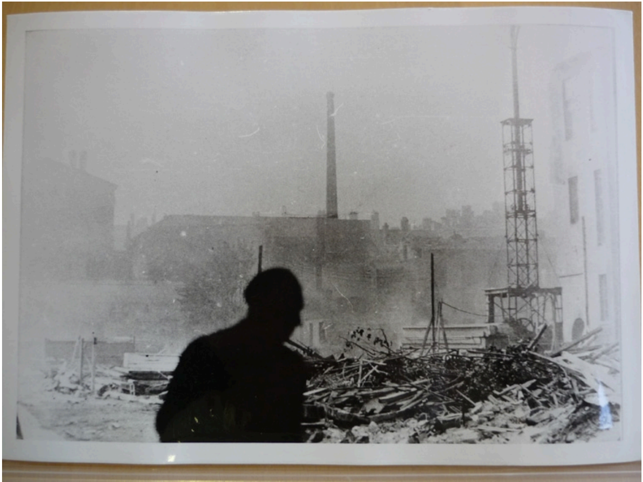
Vue d'ensemble, démolition, 1934. Photographie AC Lyon. 2PH31
