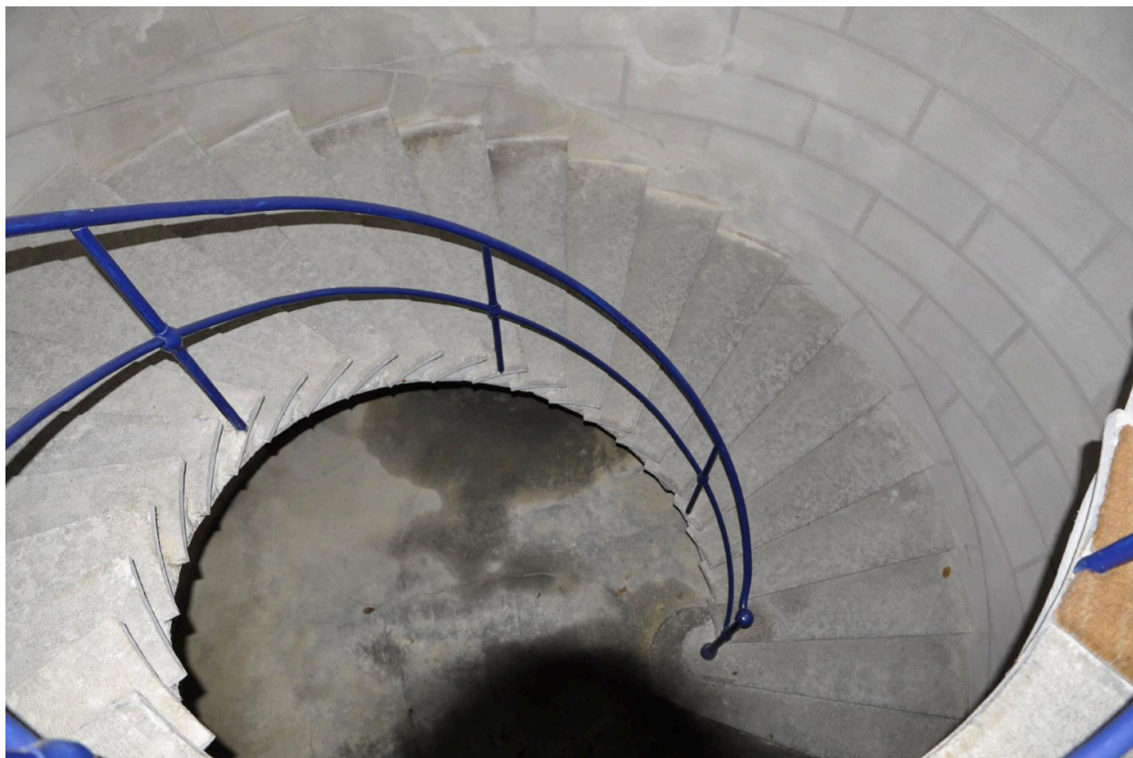
Escalier en vis suspendu, vue par dessus
