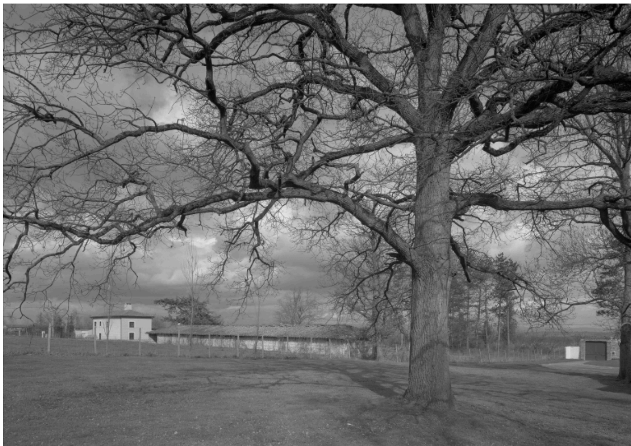
Vue générale du hangar et de la ferme du château situés aujourd'hui hors enceinte du parc, au nord du parc, de l'ouest.
