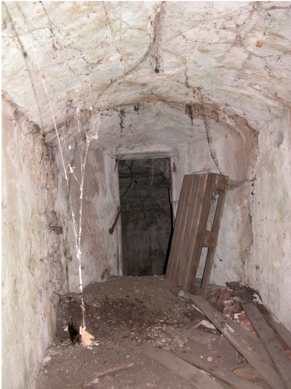
Vue intérieure du couloir d'accès au puits de la glacière.
