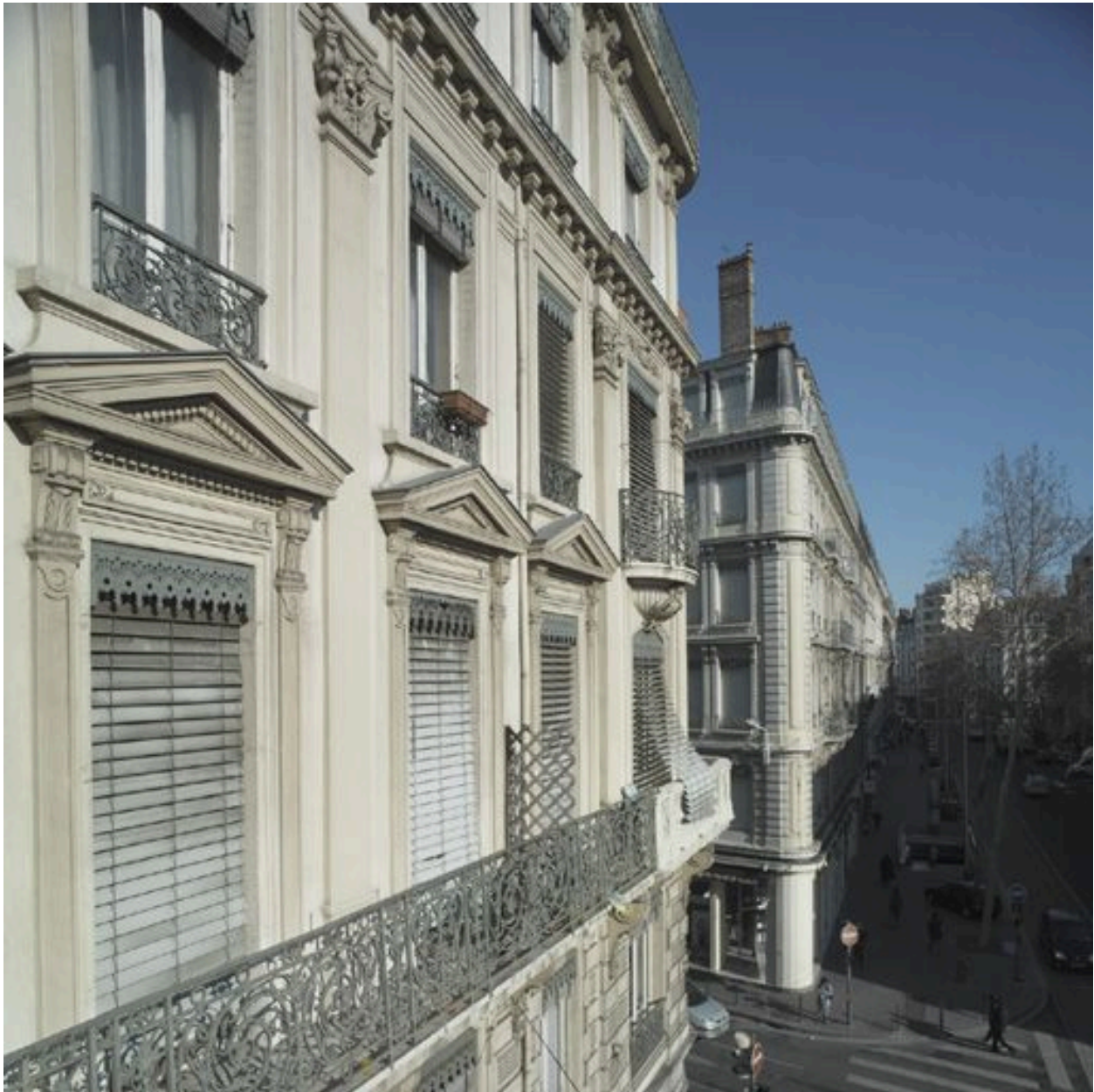
Détail du 1er étage, avenue Jean-Jaurès
