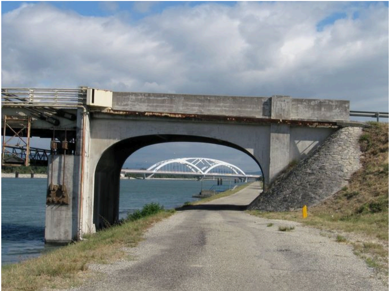
Culée passante de la rive gauche, face aval
