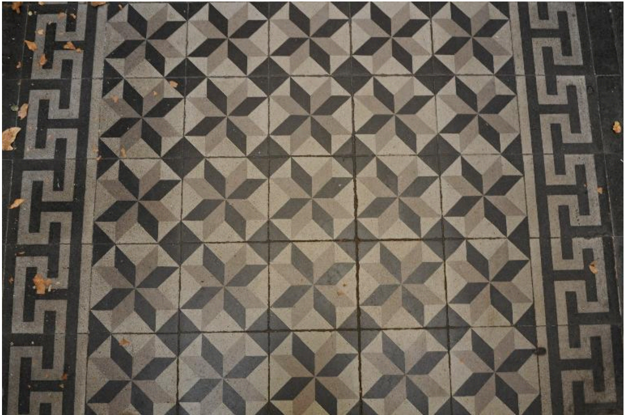
Vue intérieure, détail du pavé de l'allée
