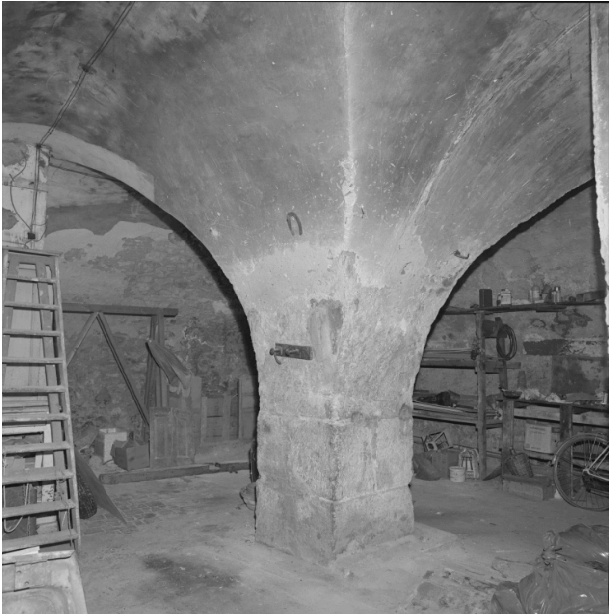
Pilier central supportant les voutes du cellier.
