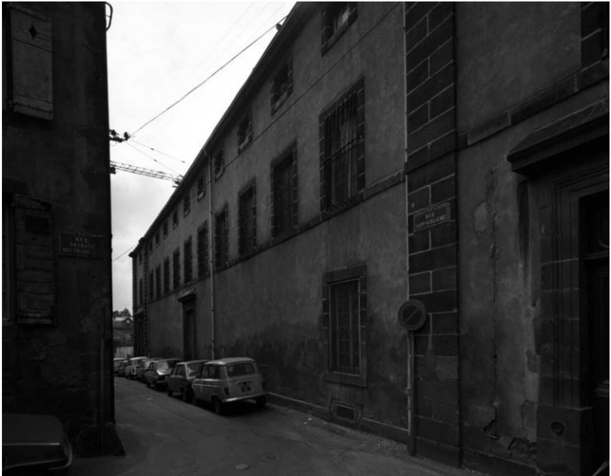
Hôtel-Dieu de Clermont-Ferrand. Le Refuge, façade nord vue du nord-ouest, état de 1981 (avant modifications).
