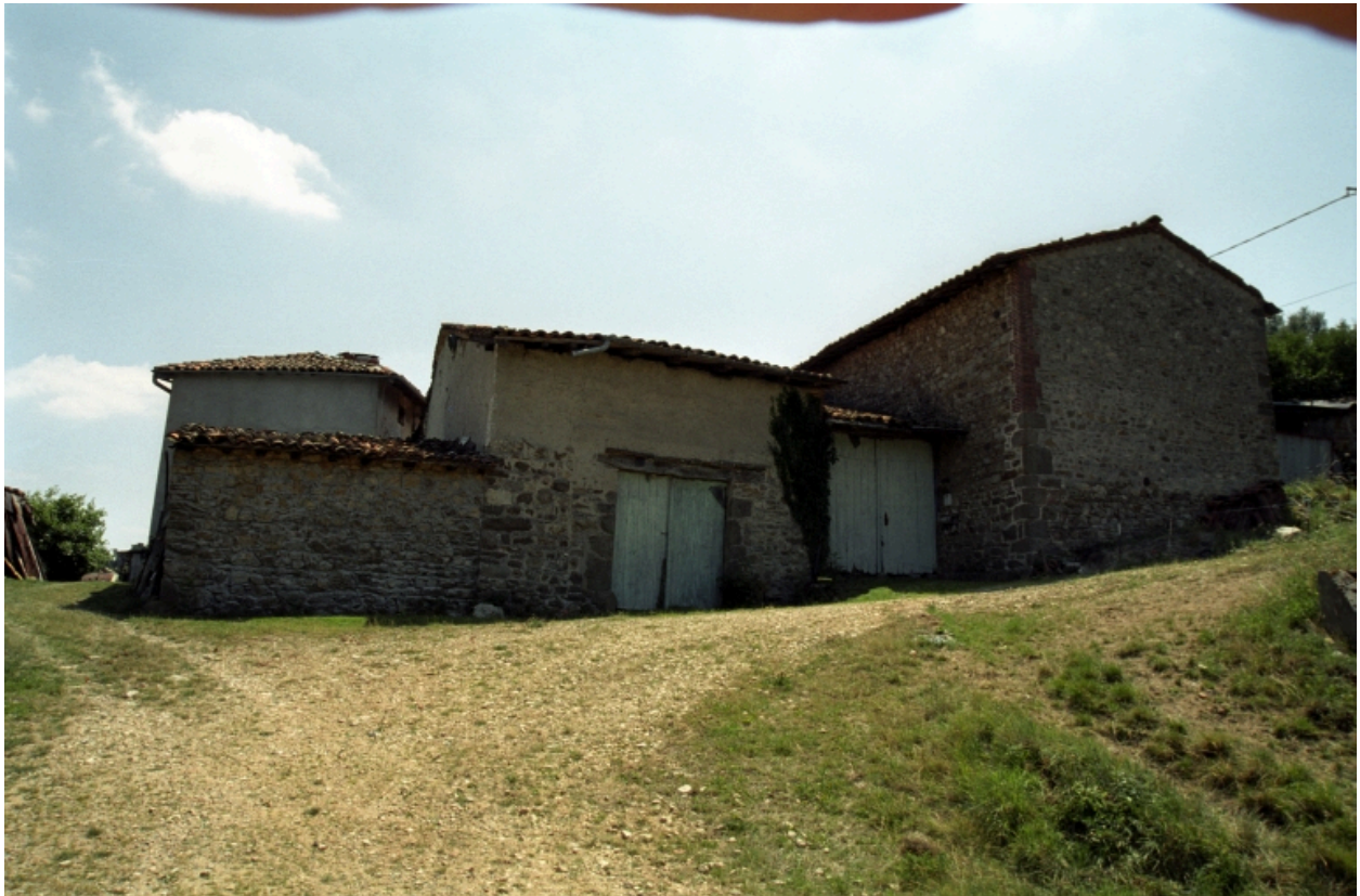
Vue d'ensemble de la ferme côté portail d'entrée de la cour fermée.
