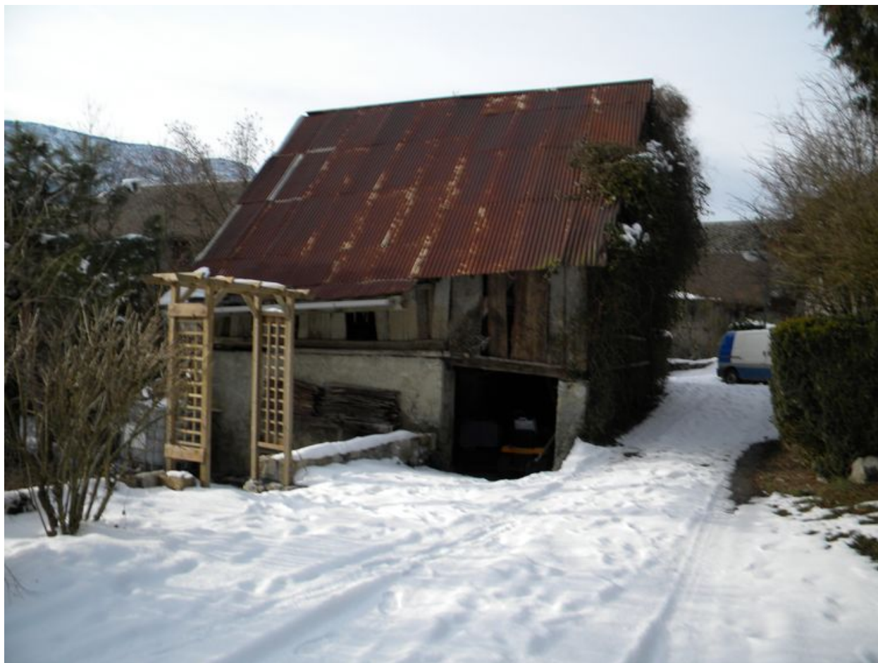
Petite grange à l'entrée de la cour, vue générale.
