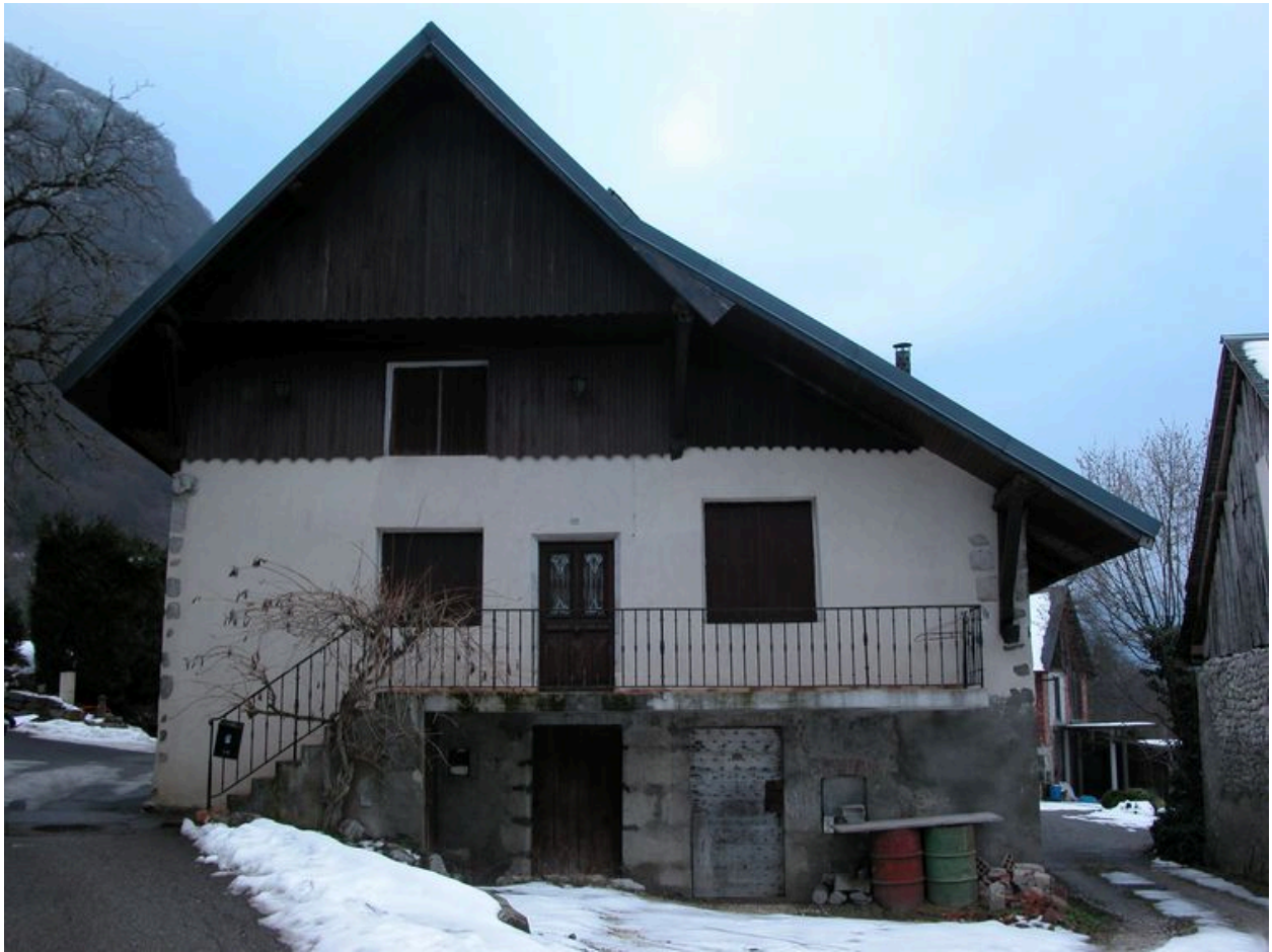
Vue de la façade principale en mur pignon
