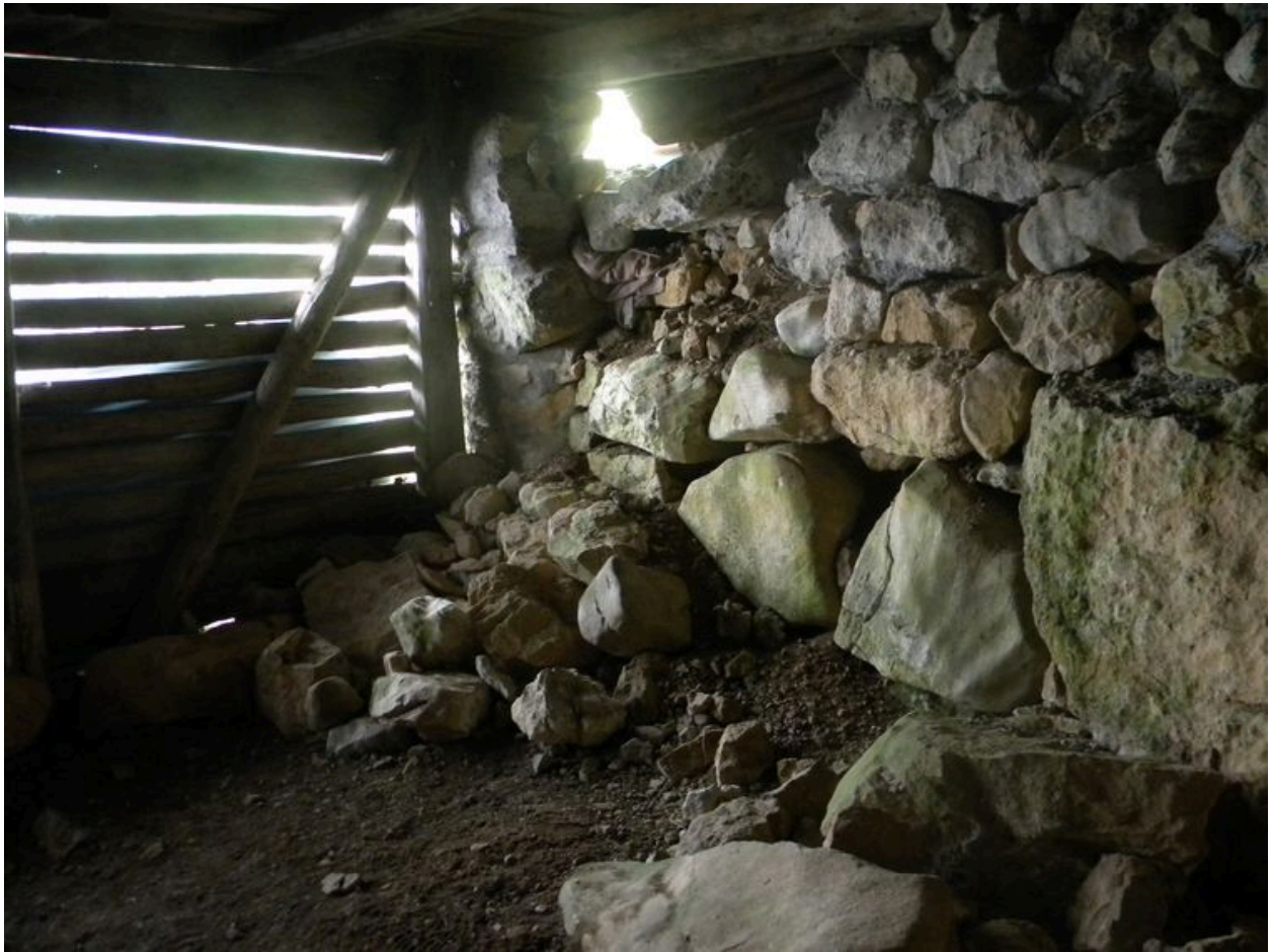
Ancien freddy avec murs en pierre et bois.
