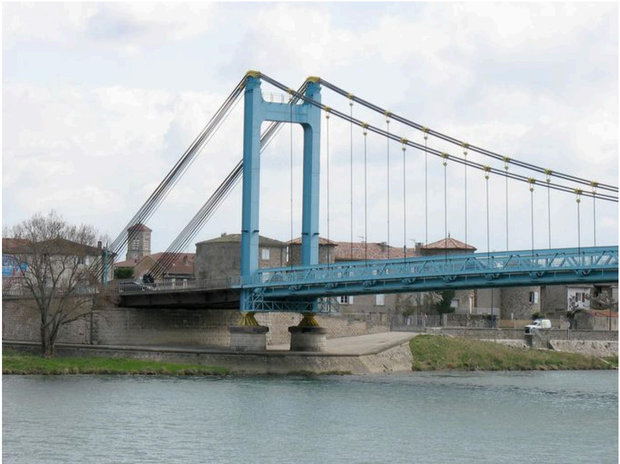
Vue partielle face amont, pylône de la rive gauche
