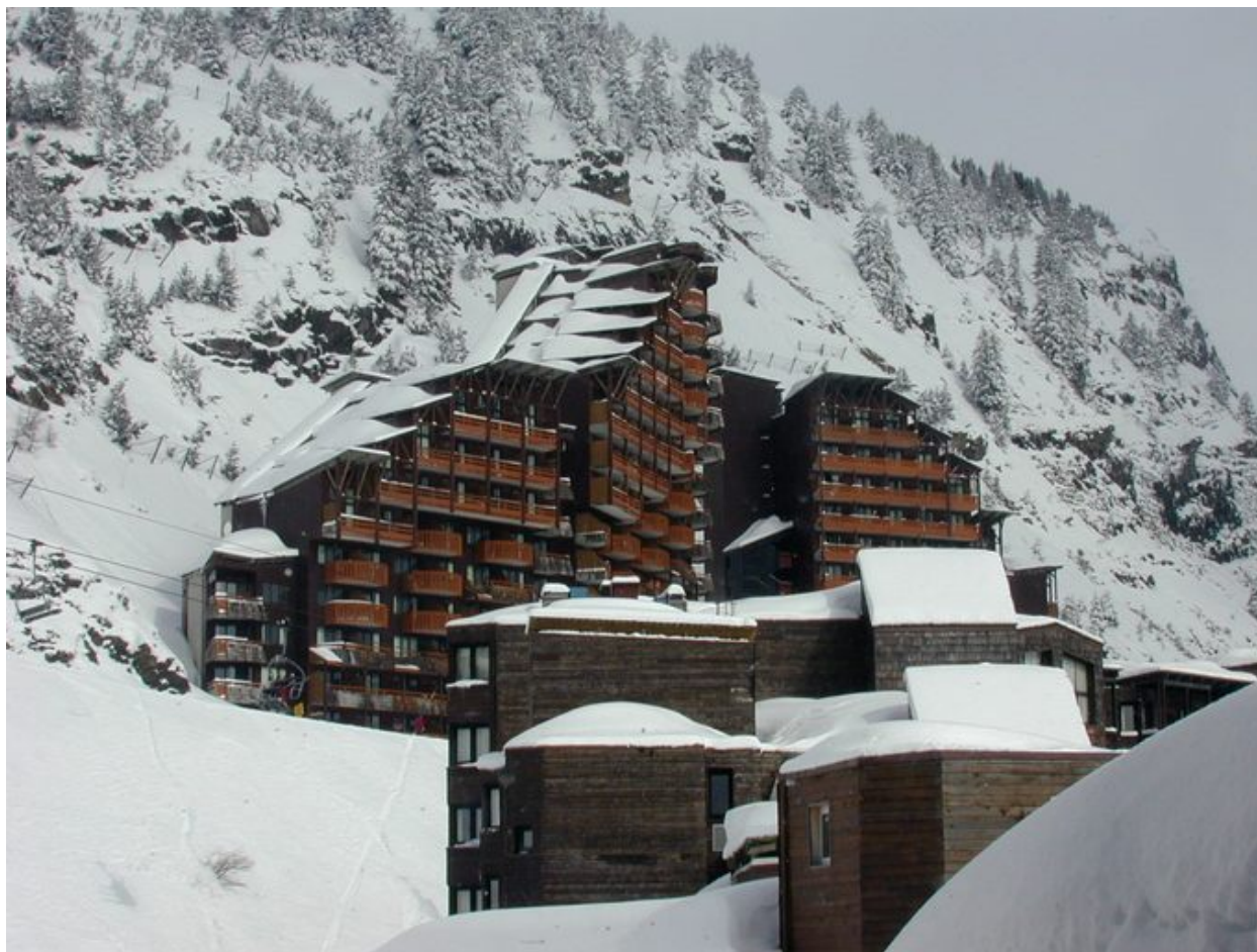
Vue générale depuis le sud-ouest
