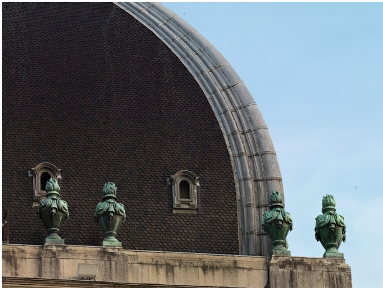
Le dôme Soufflot. Détail d'un arêtier
