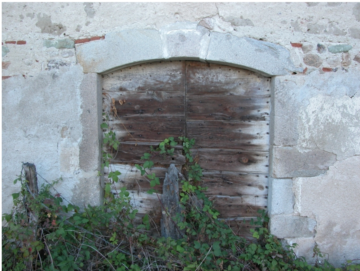
Détail de la porte sud de l'étable ou écurie ouest.
