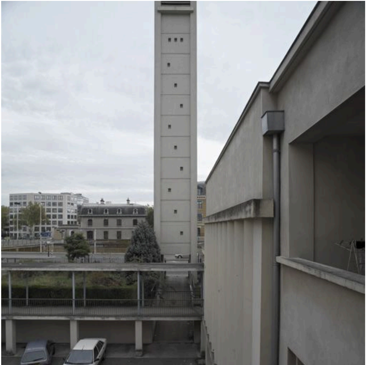
Vue du clocher et du passage couvert depuis l'ouest
