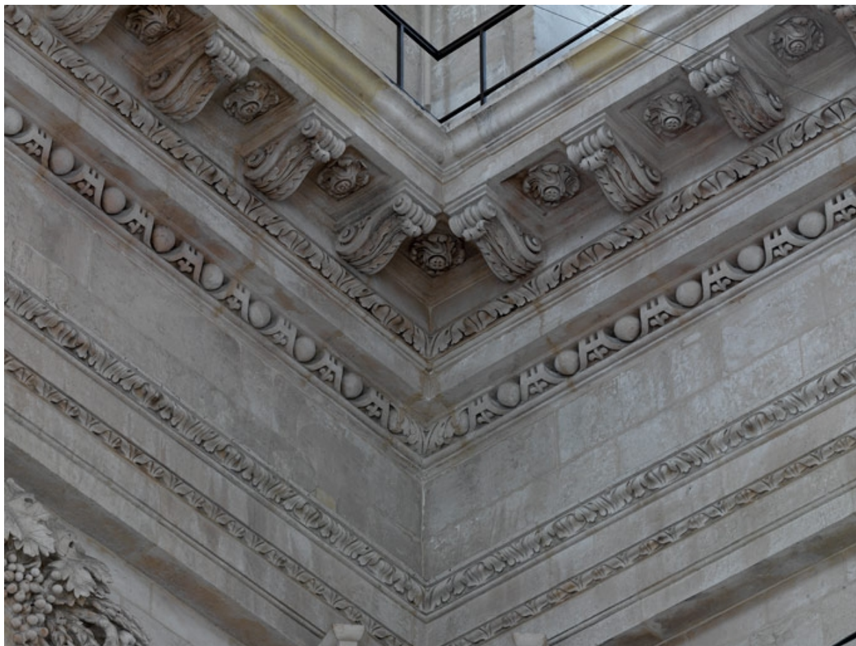
Frises et corniche supportant la galerie supérieure. Détail d'un angle
