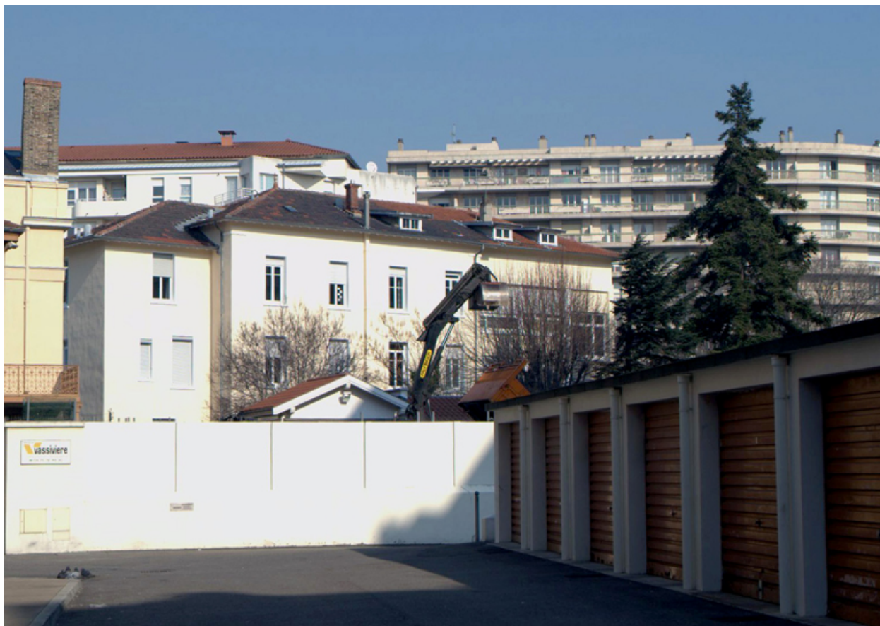
Elévation latérale sud, vue depuis le sud-ouest
