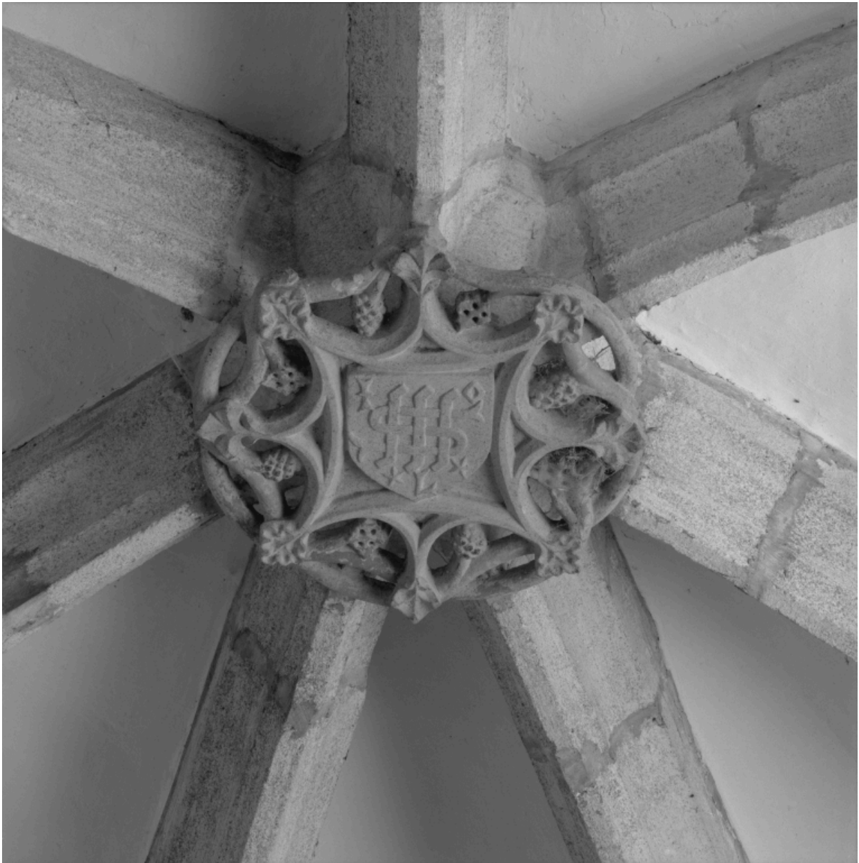
Détail de la clef de voûte du choeur.
