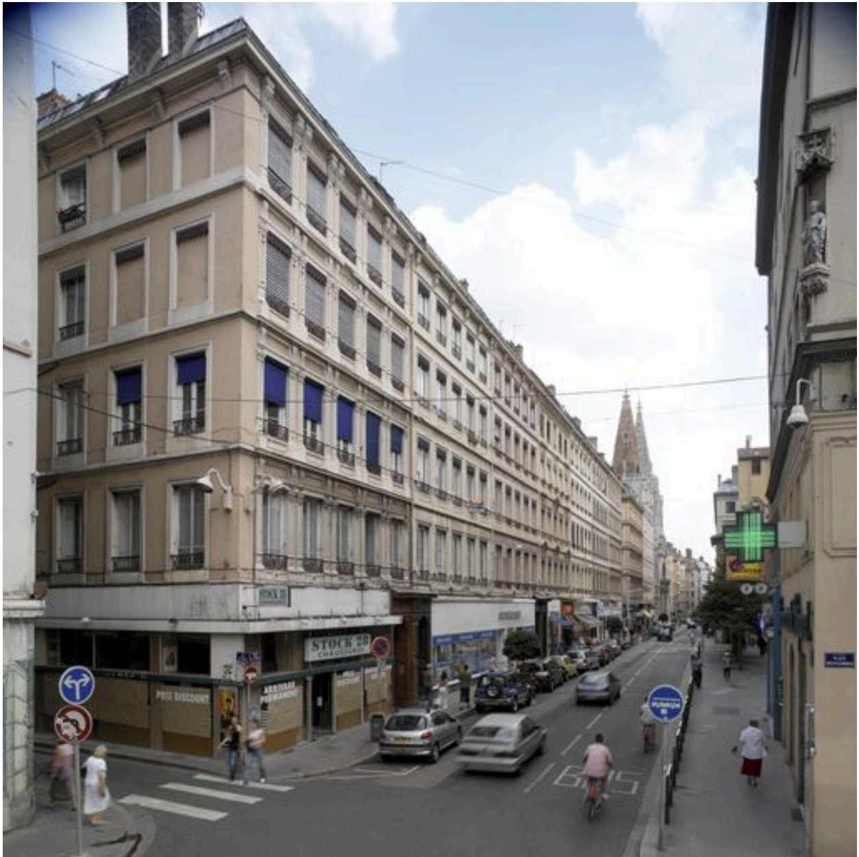
Vue de la rue Paul-Chenavard vers l'église Saint-Nizier depuis la place Meissonier
