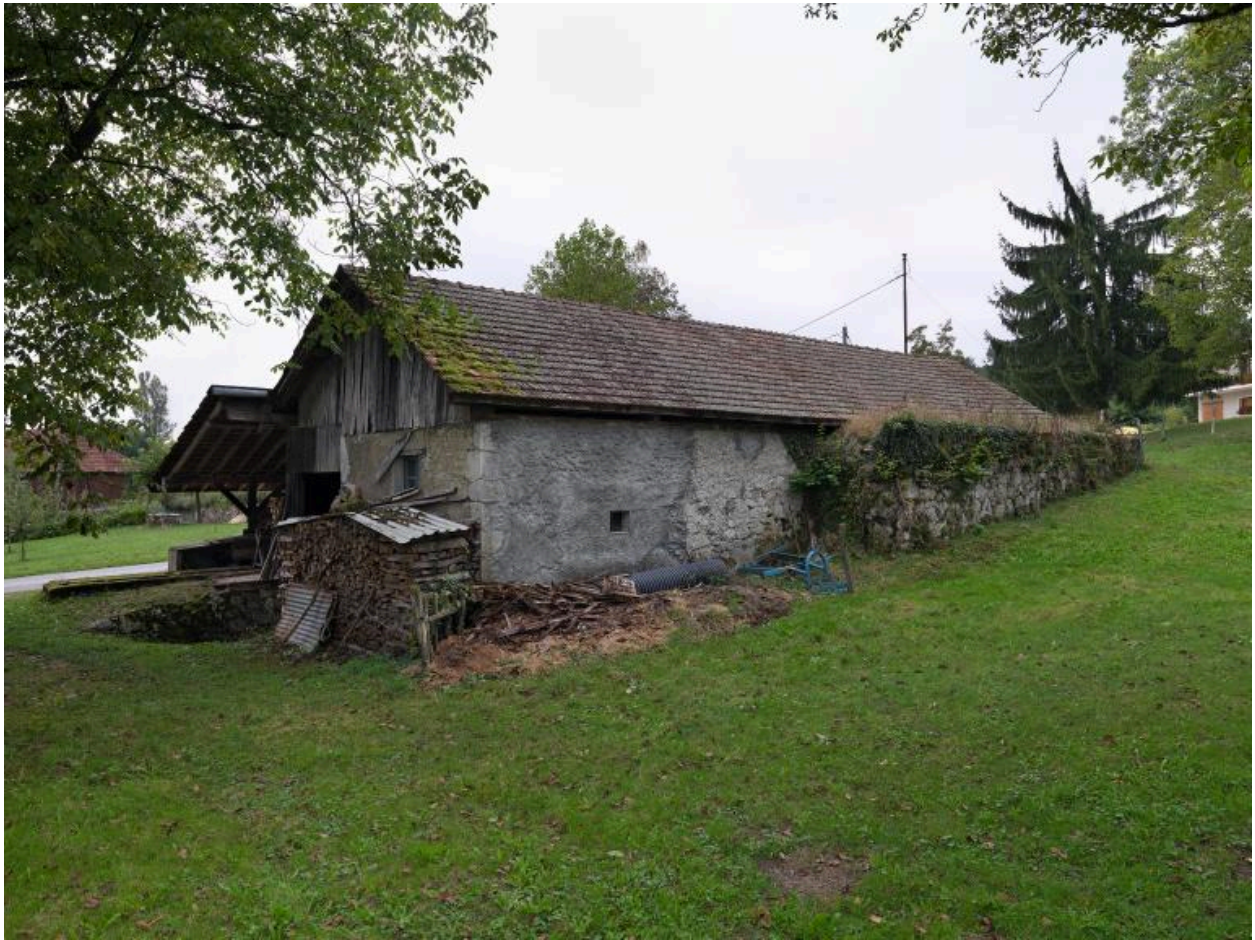
Vue de l'élévation postérieure.
