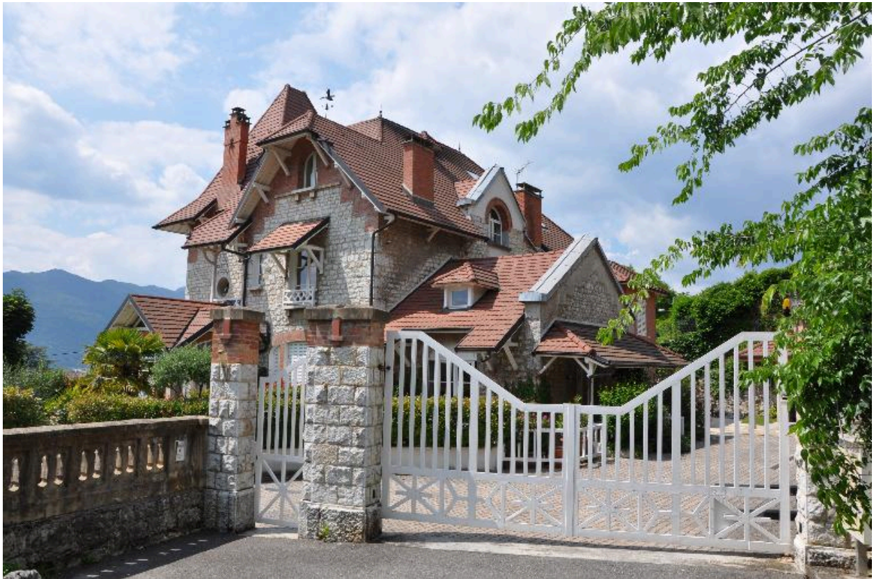
Vue des façades sud et est depuis le portail d'entrée
