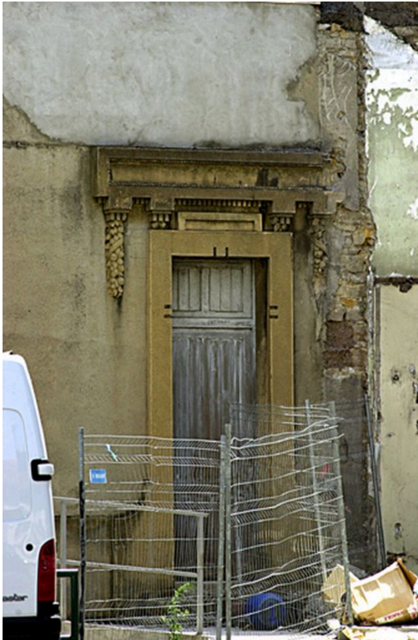
Portes murées, impasse rue Clair-Tisseur. Détail de la porte de droite
