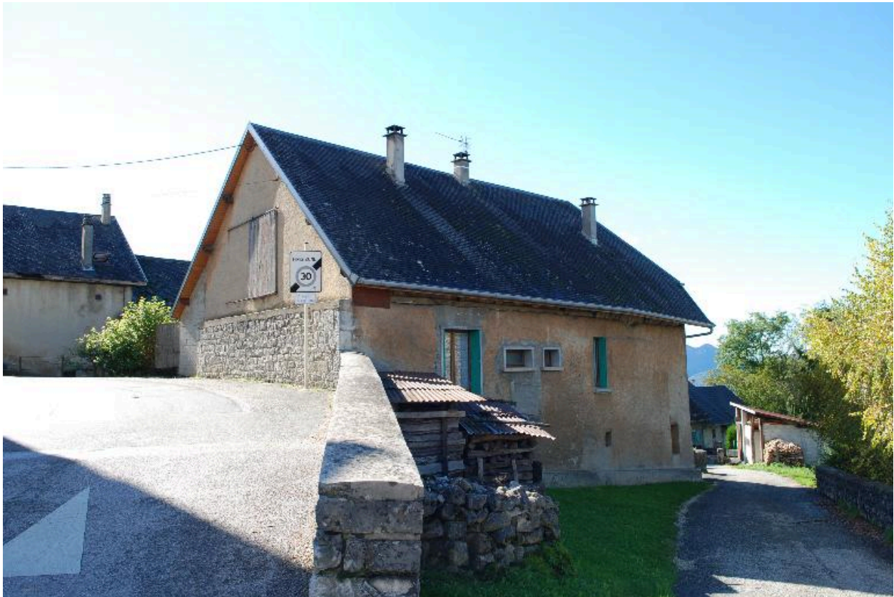
Chef-lieu, ferme, ancienne forge, 2014 B3 1228. Vue d'ensemble de trois-quarts nord-est.
