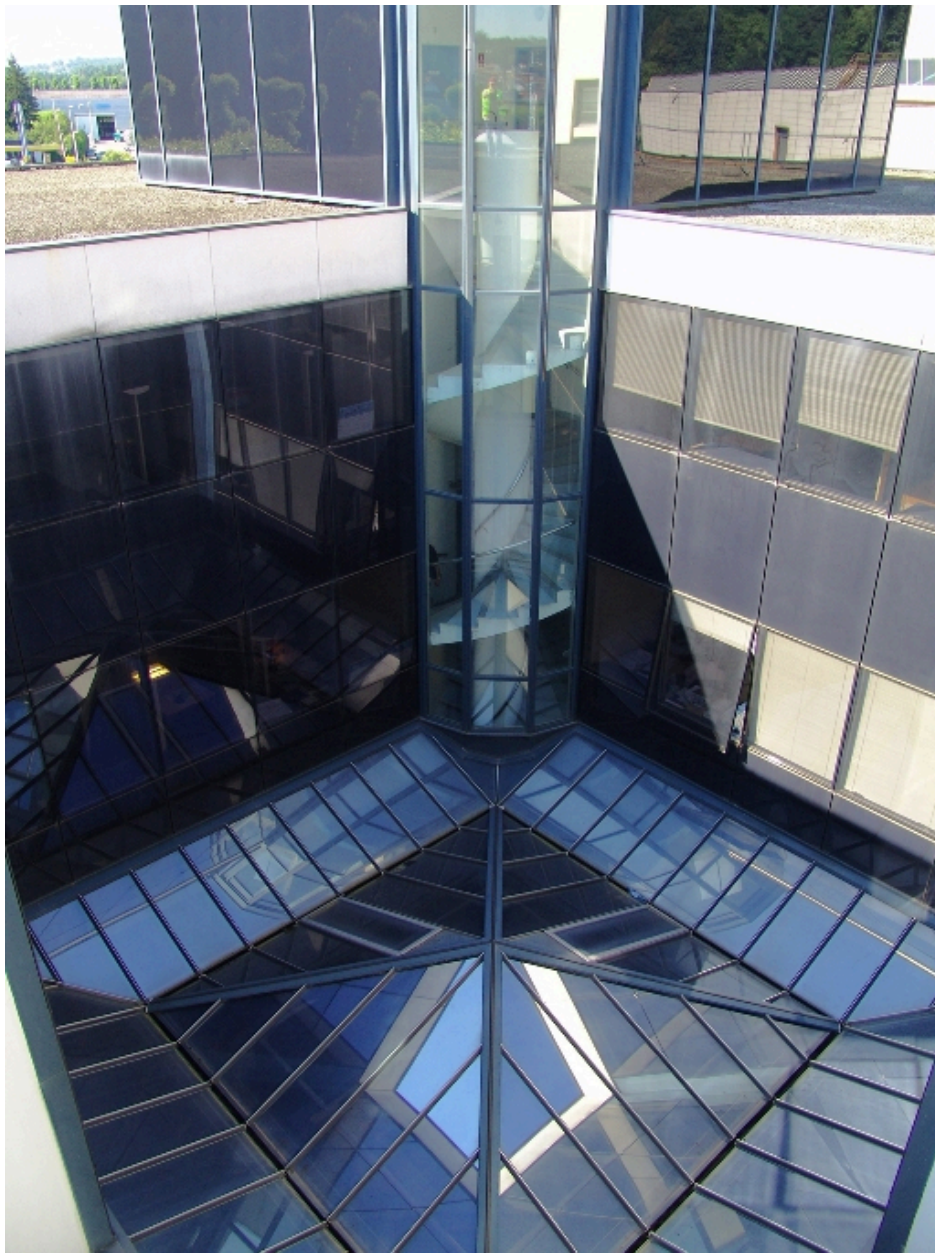
Puit de lumière avec verrière zénithale et escalier en vis
