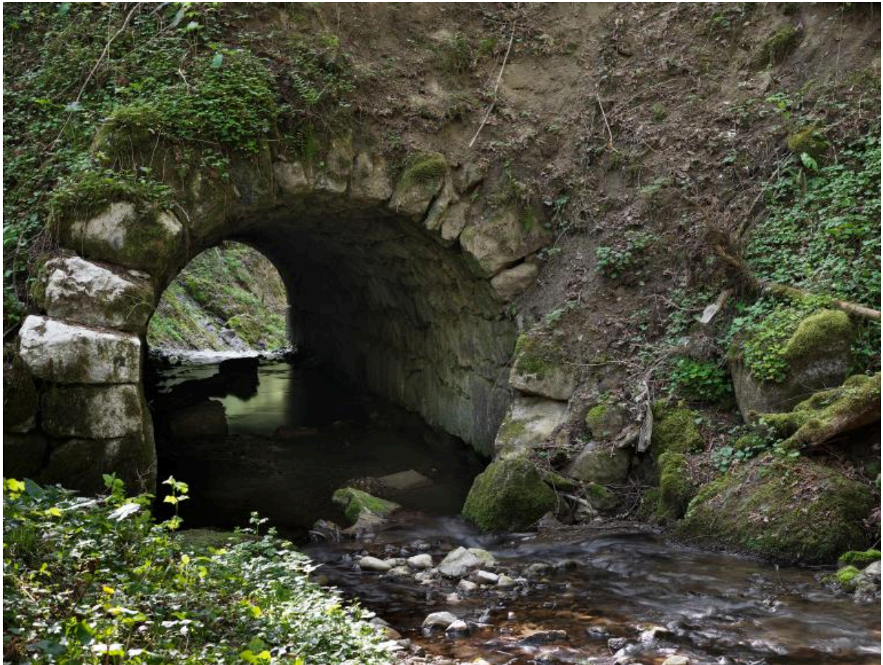
Vue rapprochée côté amont.
