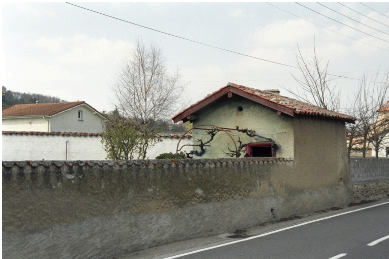
Boën, Groseiller-Ouest (1986 AK 35). Loge en rez-de-chaussée de type R1a1. Vue d'ensemble.
