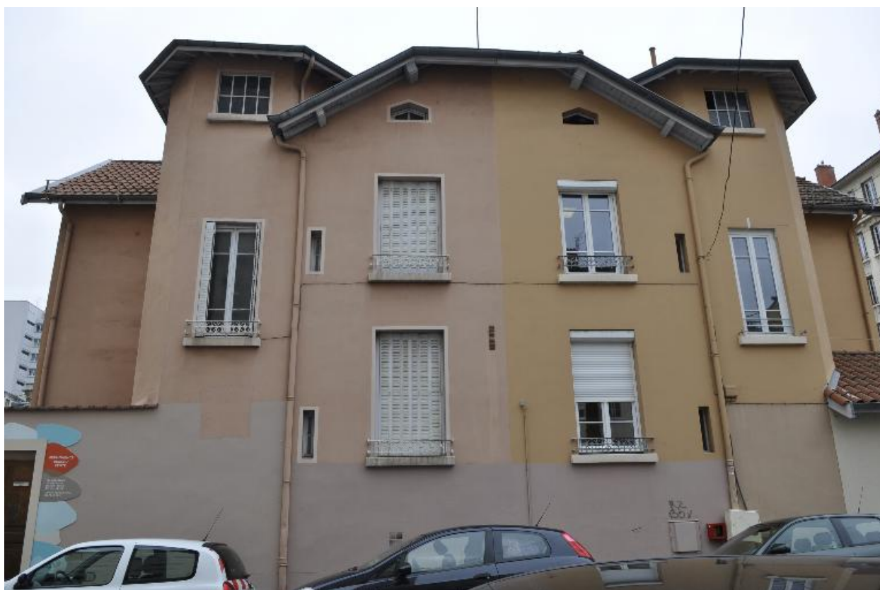
Vue de la façade nord
