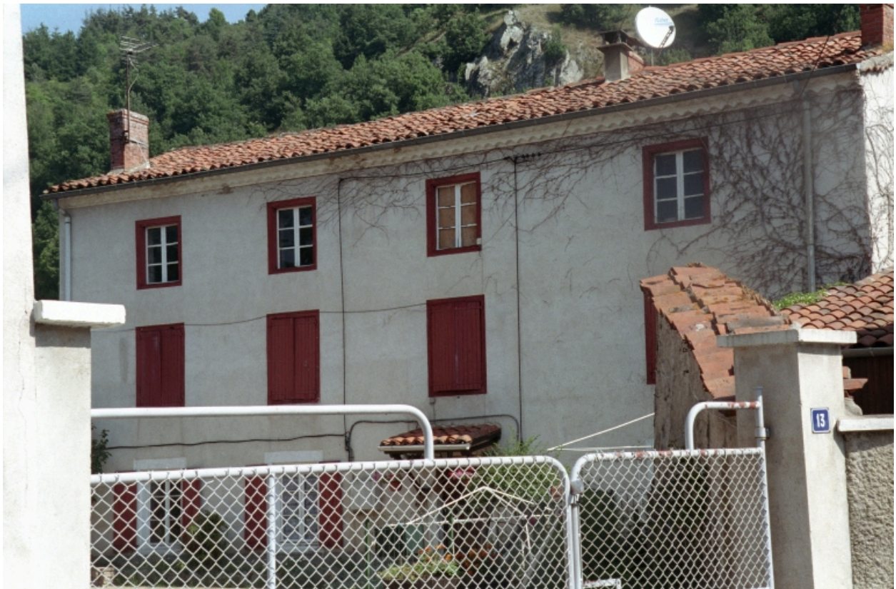
Boën, îlot 23, L'Argentière (rue de) 13. Vue générale de la façade sur cour depuis la rue.
