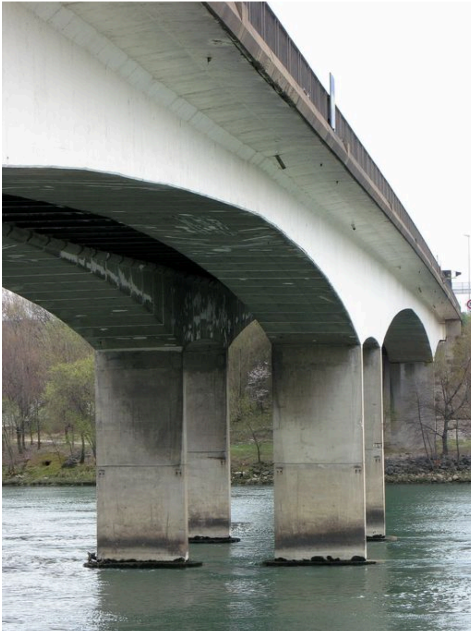
Vue partielle, côté aval, rive gauche
