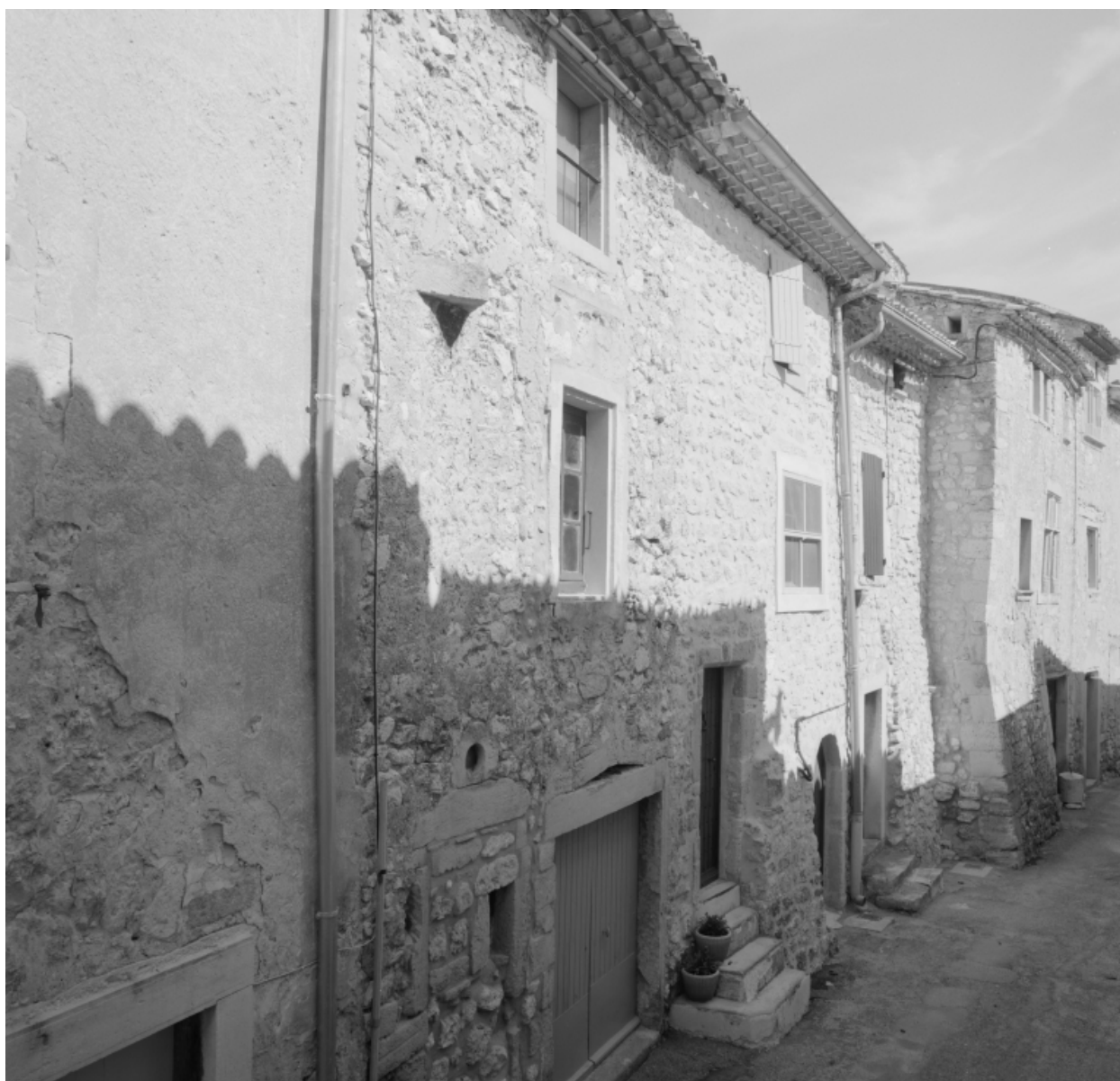
Maisons (A 677, 581, 578, 577), Grande rue (côté pair), façades.
