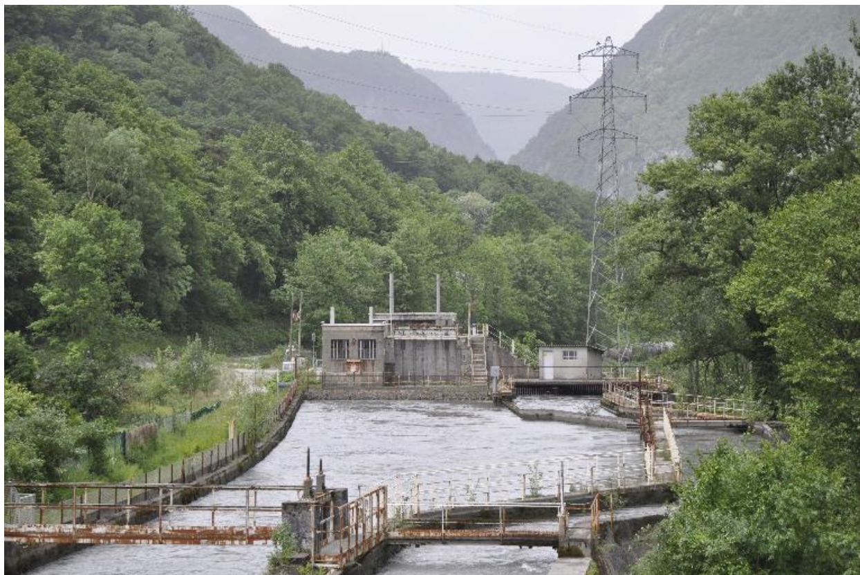
Vue d'ensemble du barrage
