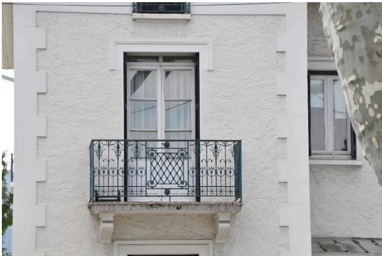
Détail d'une baie avec balcon
