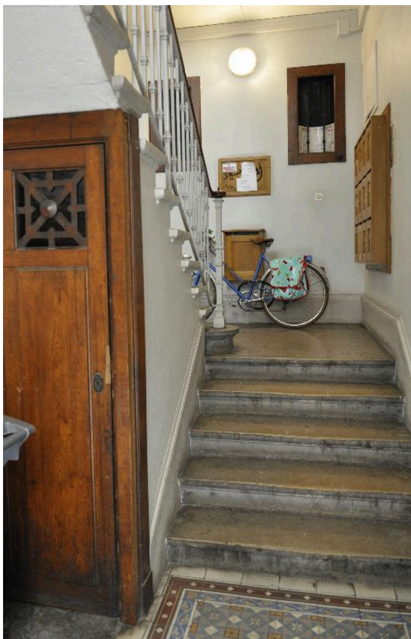
Vue intérieure : l'entrée et le départ de l'escalier en revers de façade
