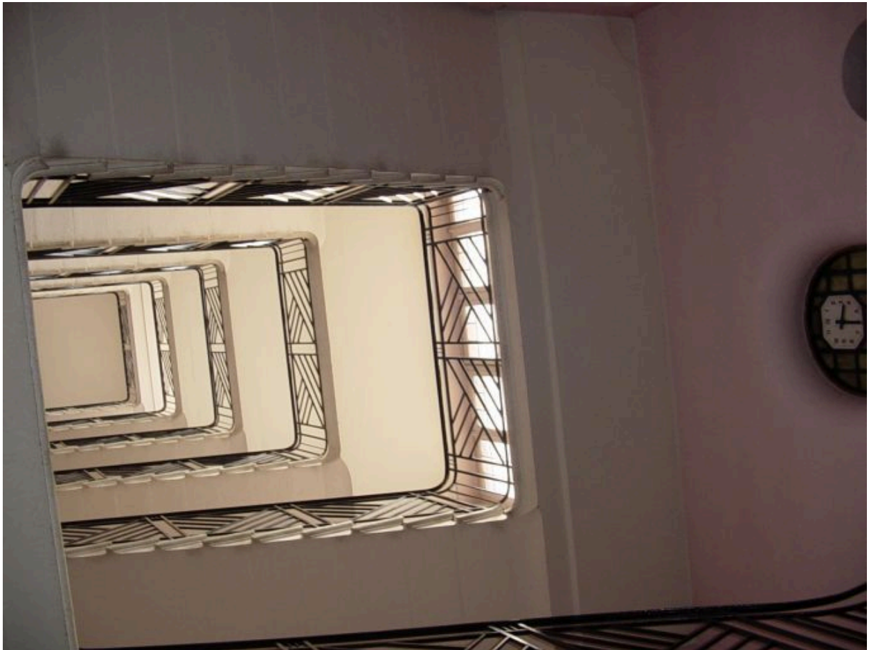
Vue de la cage d'escalier en contre-plongée
