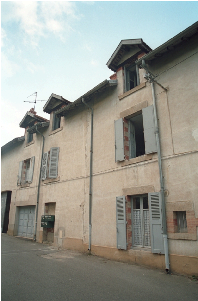
Vue d'ensemble en enfilade de la façade sur rue.
