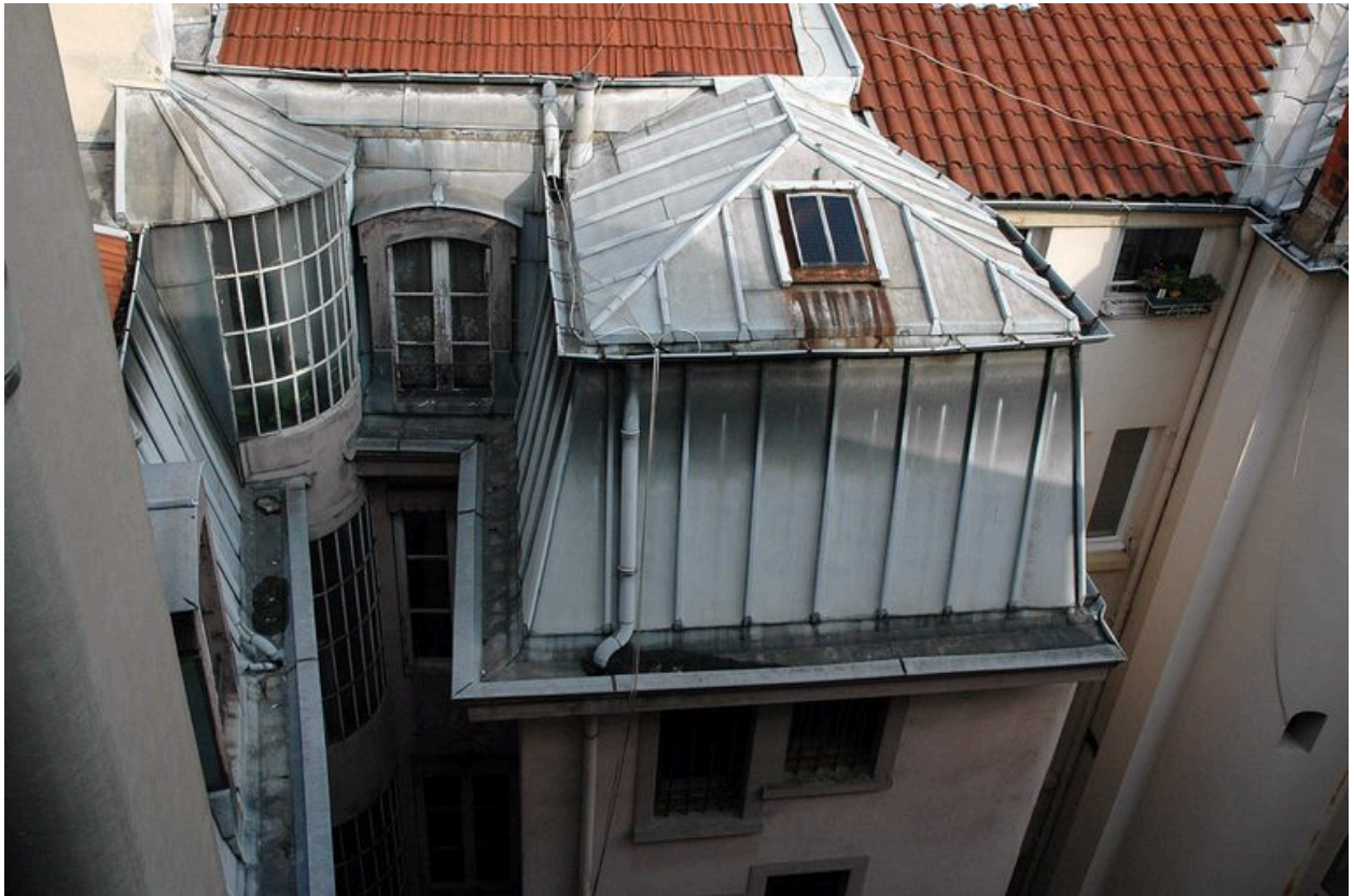
Toiture des corps de bâtiment sur cour depuis le 5 rue Thomassin
