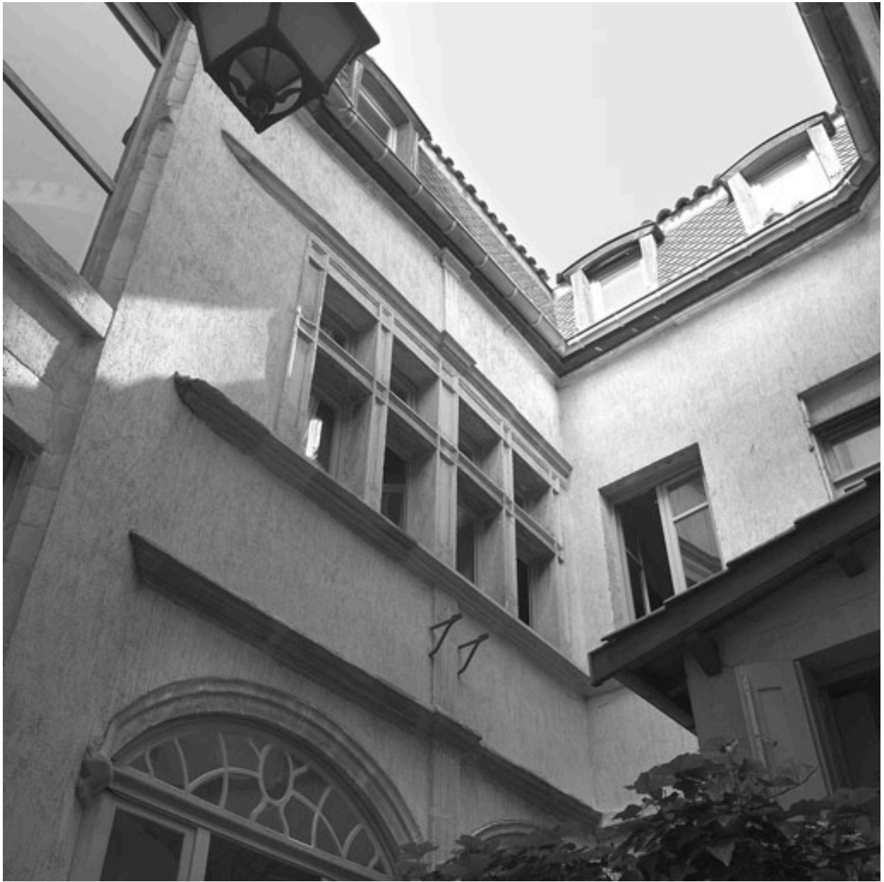
Cour intérieure, vue partielle du mur nord : croisée jumelée et bandeaux d'étages.
