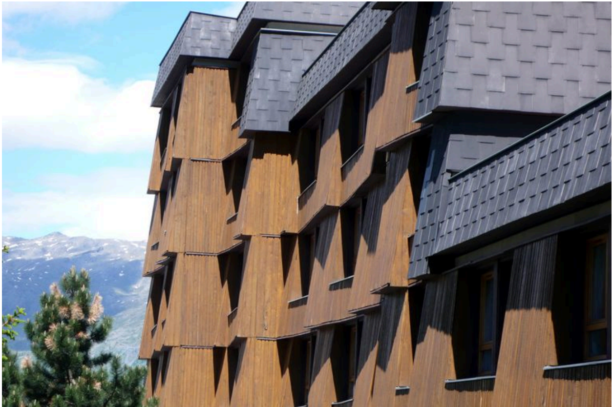
Détail de la structure de la façade, niveaux supérieurs
