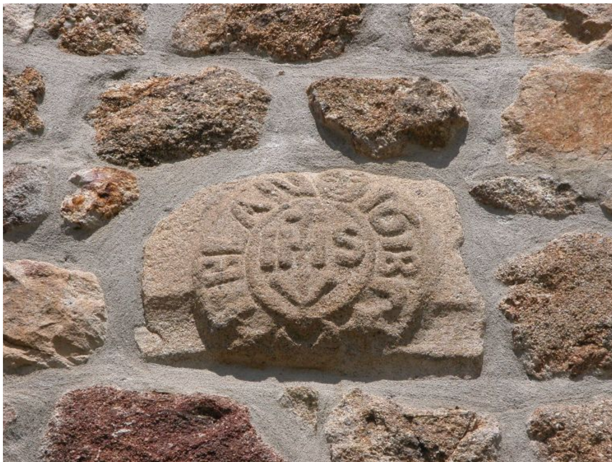
Détail d'une pierre sculptée en remploi dans la façade du logis.
