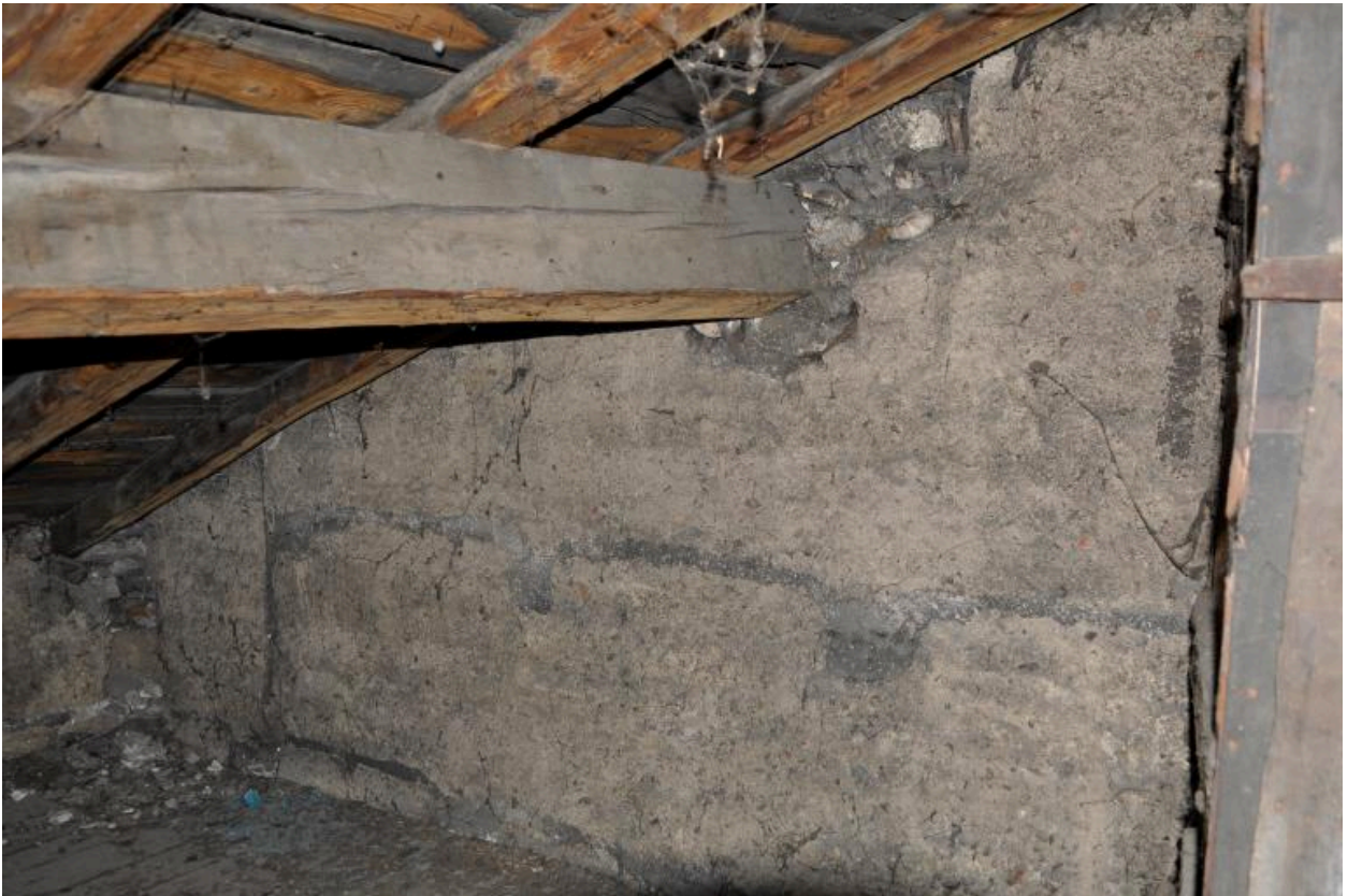
12 grande rue de Vaise : mur en pisé dans les combles
