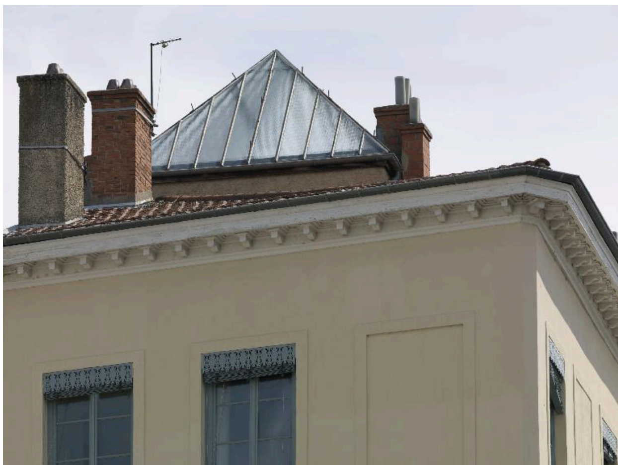
Vue de la verrière depuis la Grande rue de la Croix-Rousse
