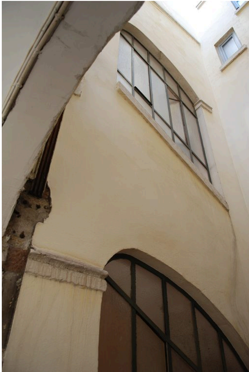
Vue partielle de la cage d'escalier depuis la courette est
