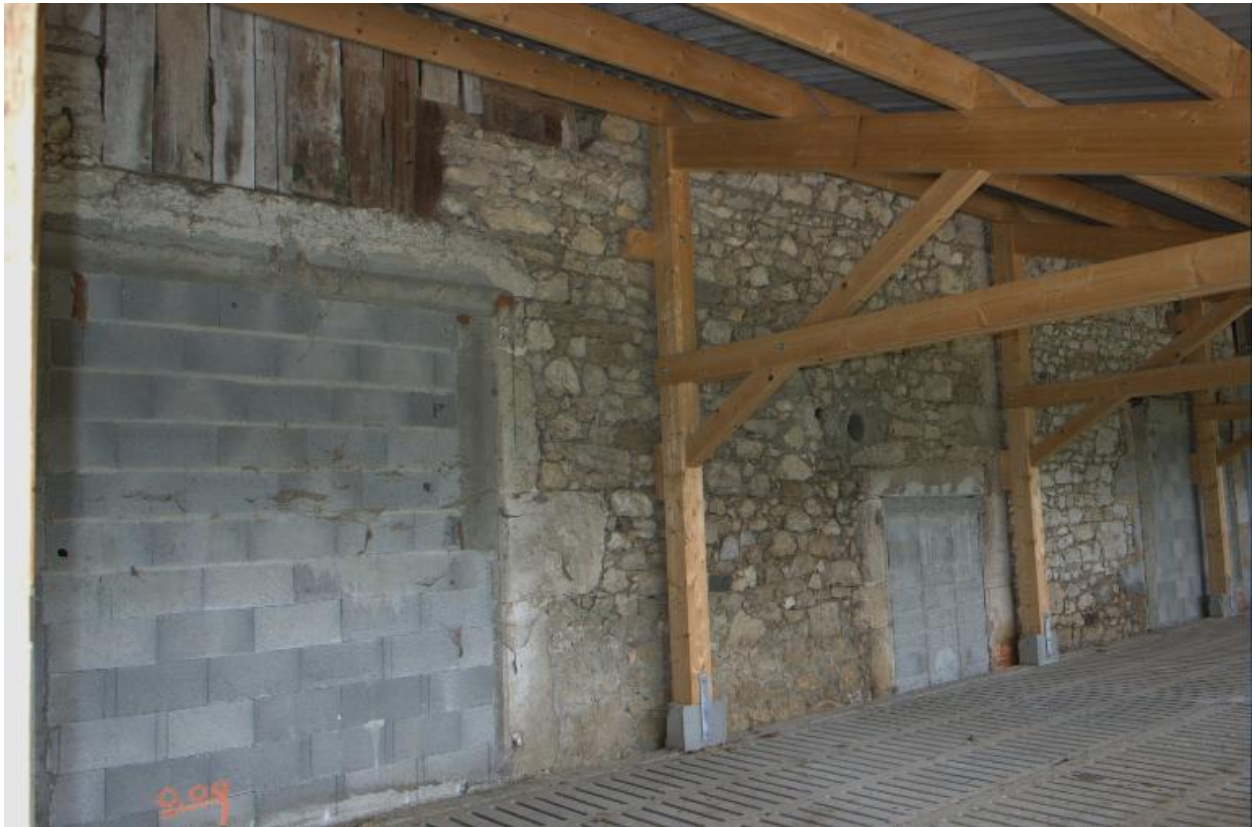
Façade arrière des coomuns depuis l'intérieur d'une remise en moellon de ciment.
