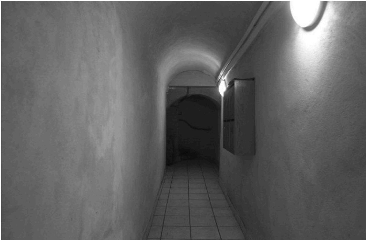
Allée, vue vers l'escalier
