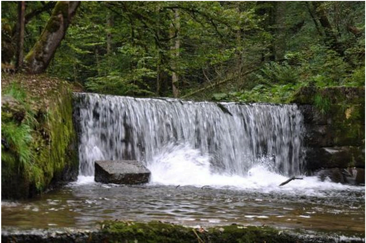
Seuil supérieur du barrage
