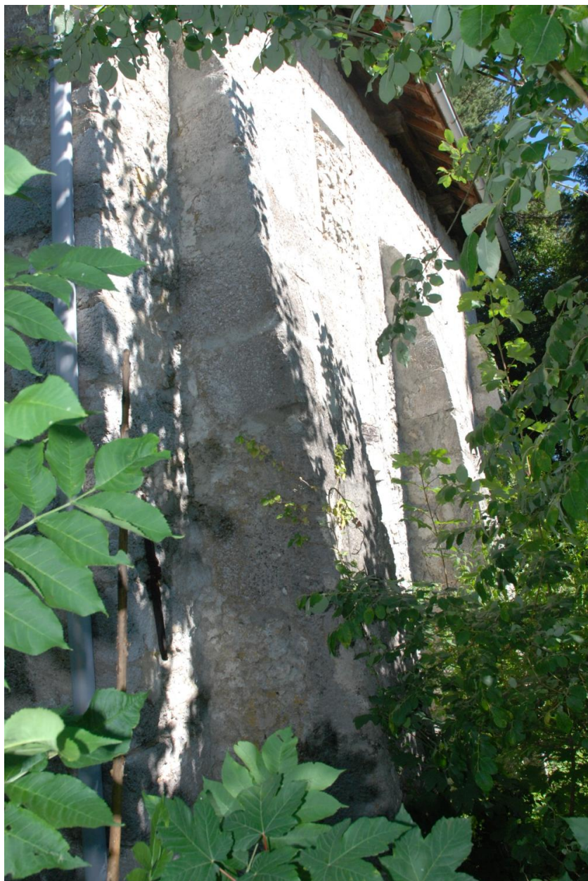
Bâtiment ouest, contreforts.
